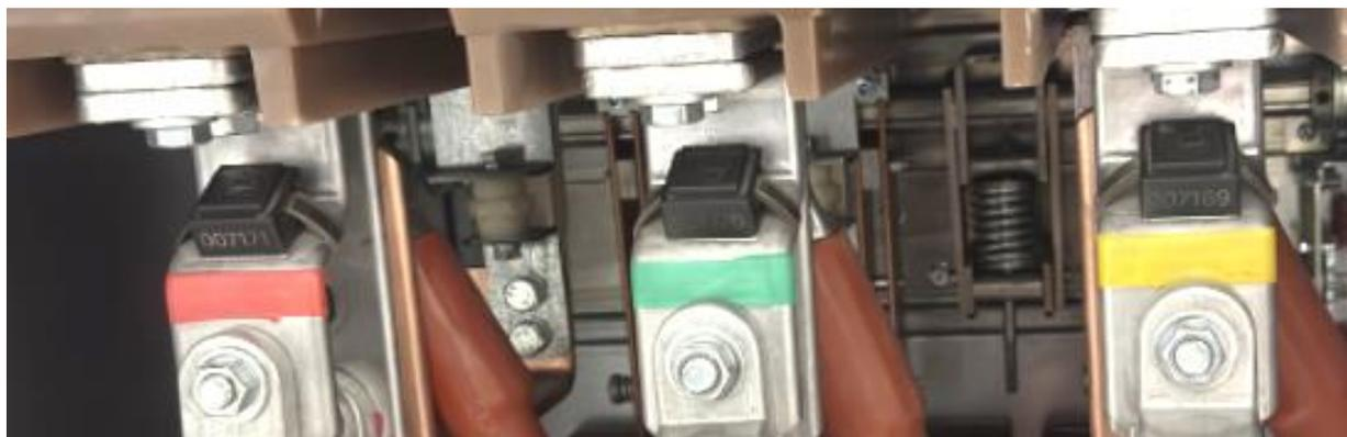
Рисунок – Датчики температуры STS 1011
