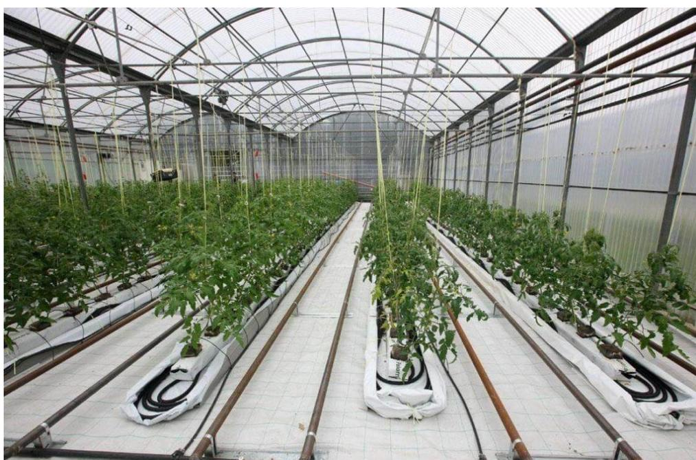
Рисунок 1 – Устройство теплицы и необходимое оборудование для подогрева почвы
